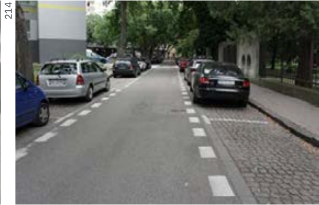
Andezit / betónová dlažba → parkovanie Pravidelný štiepaný prírodný kameň (kocka) ukladaný do vejára
