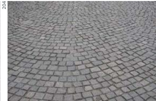
Andezit → Pravidelný štiepaný prírodný kameň (kocka) ukladaný do vejára
