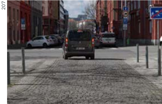
Andezit / pojazdné plochy → Pravidelný štiepaný prírodný kameň (kocka) ukladaný do vejára
