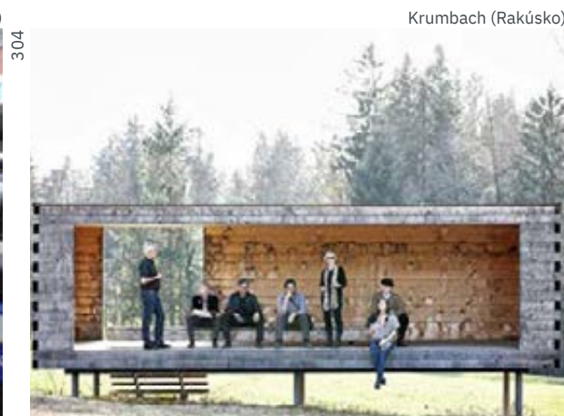
Atypická zastávka - dielo v architektúre Materiál: -
