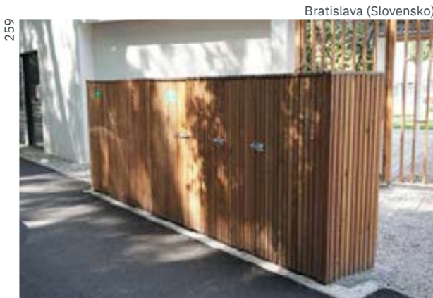
Vizuálna eliminácia nadzemných prvkov TI Materiál: drevo / kov / zeleň
