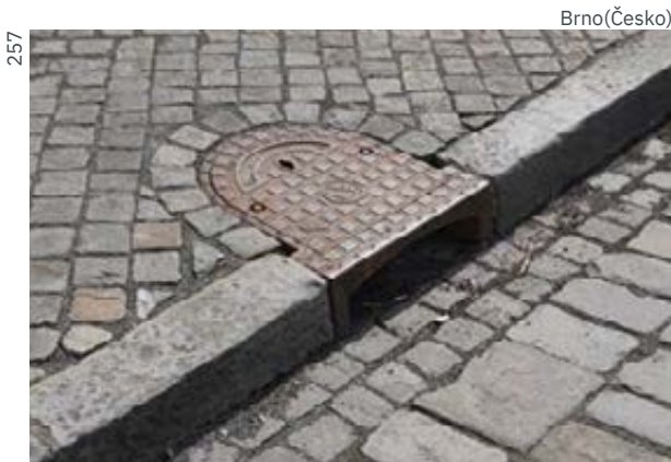
Odvod dažďovej vody v hrane chodníka Materiál: kov
