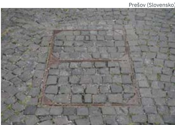
Vizuálna eliminácia poklopu TI Materiál: kov, materiál okolitého povrchu
