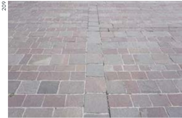
Porfýr → Pravidelný štiepaný prírodný kameň veľkého formátu
