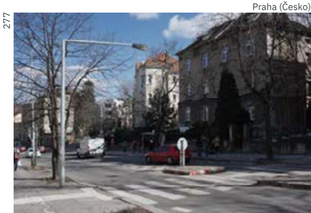
Osvetlenie prechodu s difúzerom (zabraňuje oslneniu vodiča) Materiál: kov
