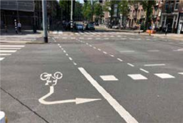
Bezpečná križovatka s vedením cyklistov po vozovke s nepriamym odbočením vľavo
