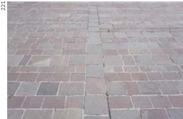
Porfýr Pravidelný štiepaný prírodný kameň veľkého formátu
