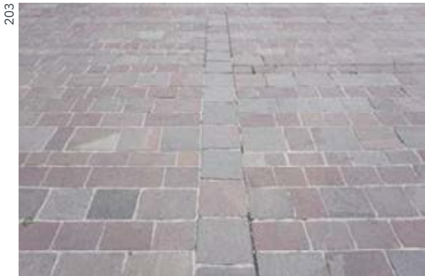
Porfýr → Pravidelný štiepaný prírodný kameň veľkého formátu
