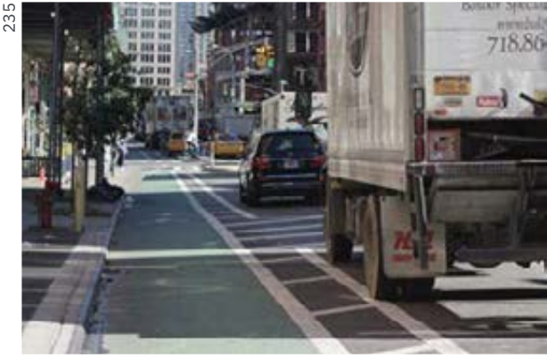
Pásky na vozovke Farebný pruh s bezpečnostným odstupom od parkujúcich áut
