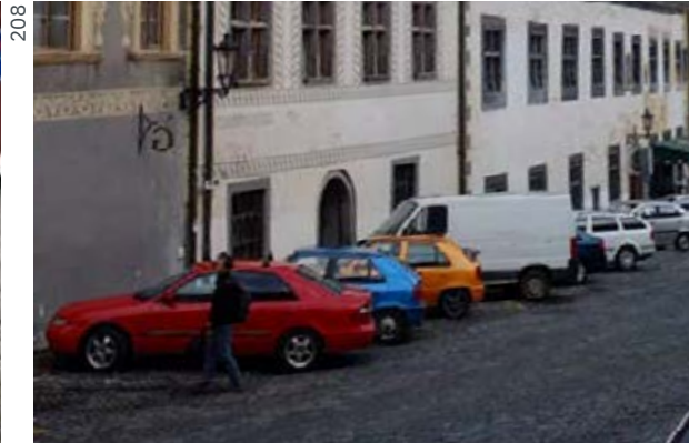
Andezit / parkovanie → Pravidelný štiepaný prírodný kameň (kocka) ukladaný do vejára
