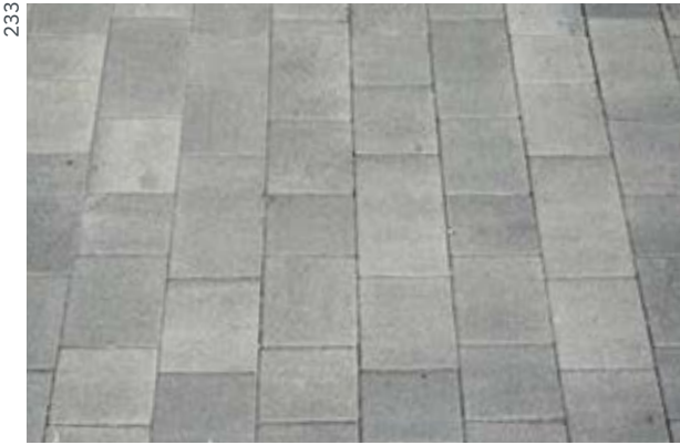
Betónová maloformátová dlažba dlažba Pravidelná betónová dlažba malého formátu
