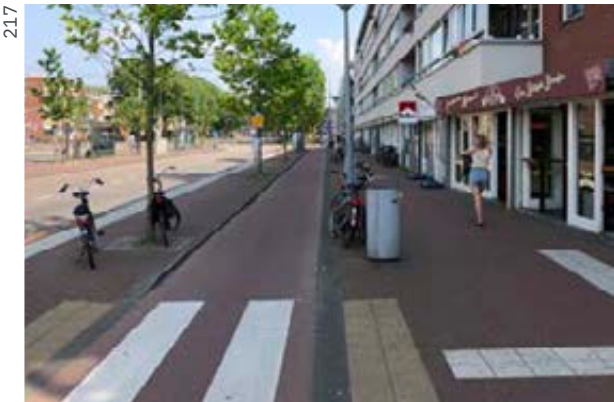
Asfaltový pruh s chodcami Oddelený farebne a výškovo od chodníka
